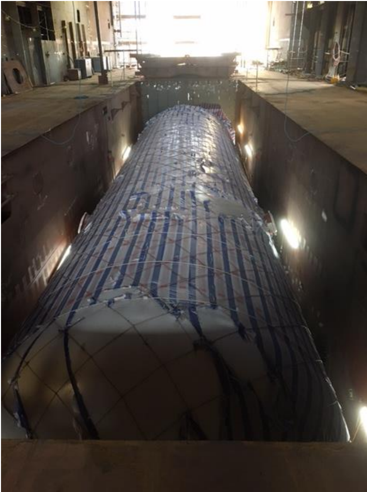
Vessel 1 – LNG Tank in Position
